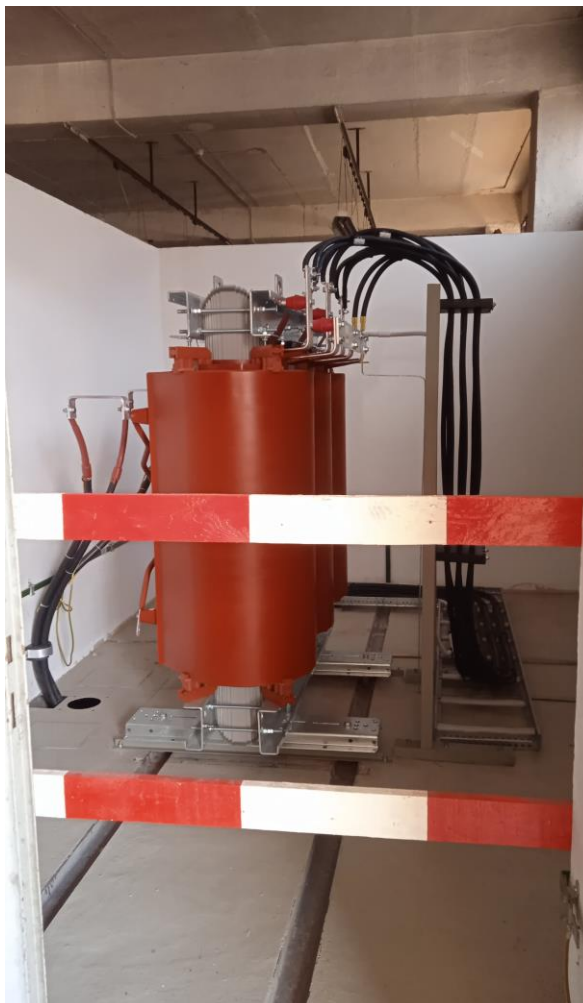
Trafo T1-1000kVA rekonstruované v 2022.
