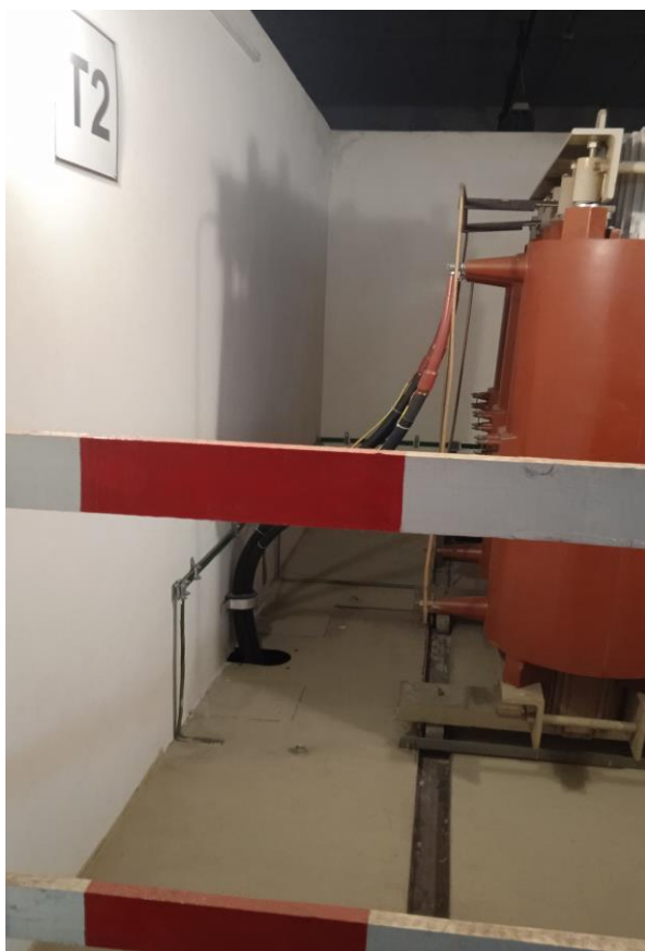
Strana vn stávajícího trafo T2-1000kVA
