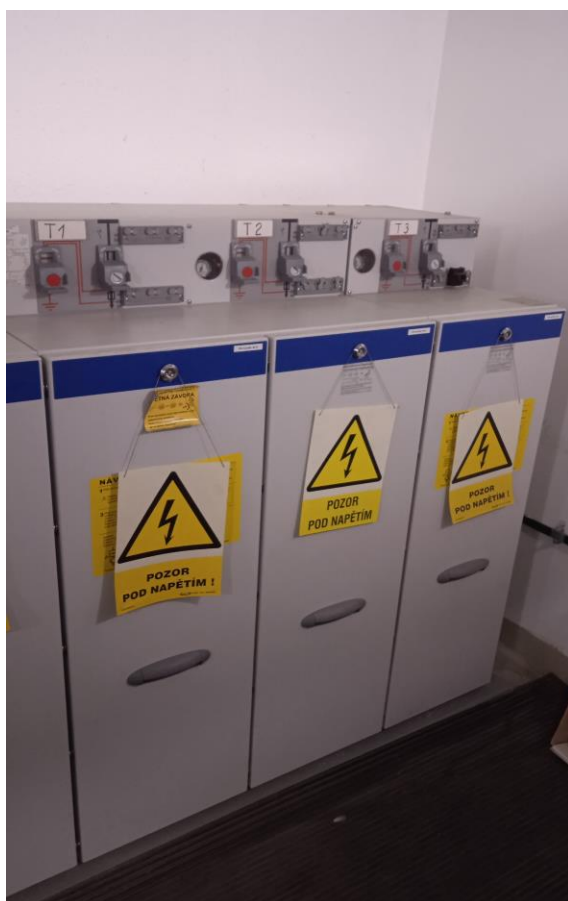
Odběratelská část stávajícího vn rozvaděče R22 ( předposlední pole - vývod na trafo T2 )
