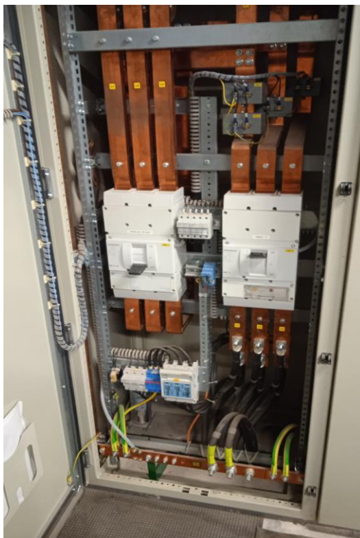
Stávající výzbroj přívodního pole rozvaděče RM2.
