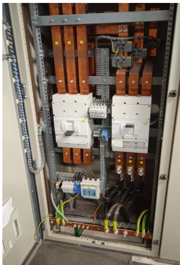
Přívodní pole stávajícího hlavního rozvaděče RM2.1 ( vlevo odpínač, vpravo hl. jistič )
