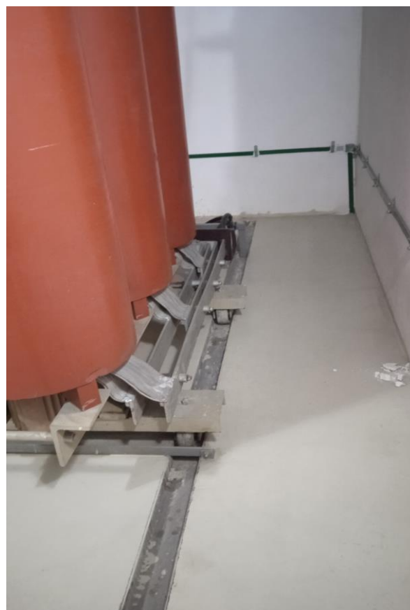
Strana nn stávajícího trafo T2-1000kVA
