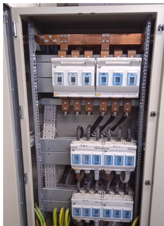
Stávající výzbroj RM2 pole 2 QSU2 vlevo nahoře, QSU3 vpravo nahoře Pro “ nový “ vývod “ krasohala “ QSU2.
